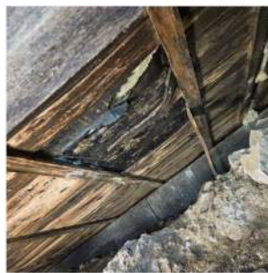
Våren 2025 renoverades endast ett hus (6) pga. ett mer omfattande arbete
